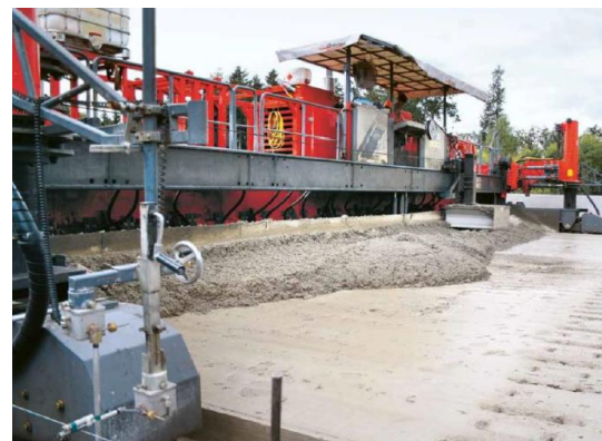
Mise en œuvre
