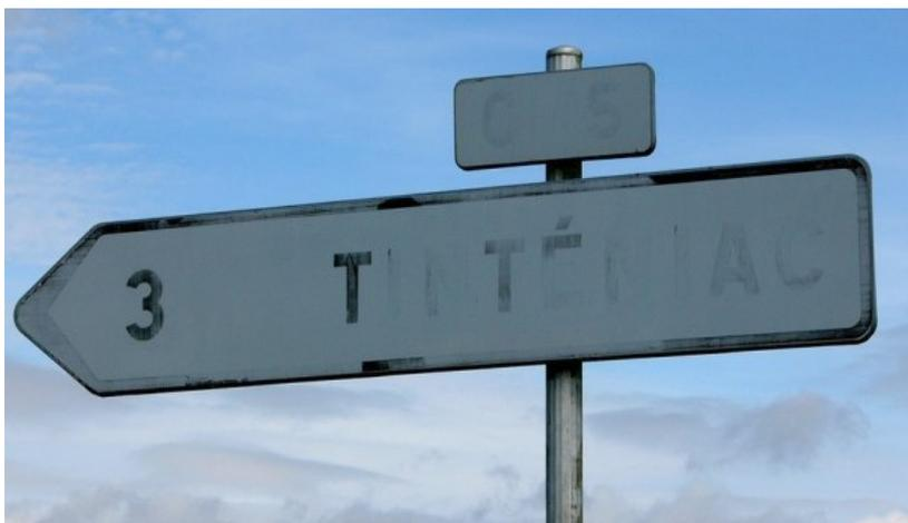
**Figure 5** : Exemple de signalisation verticale dégradée
