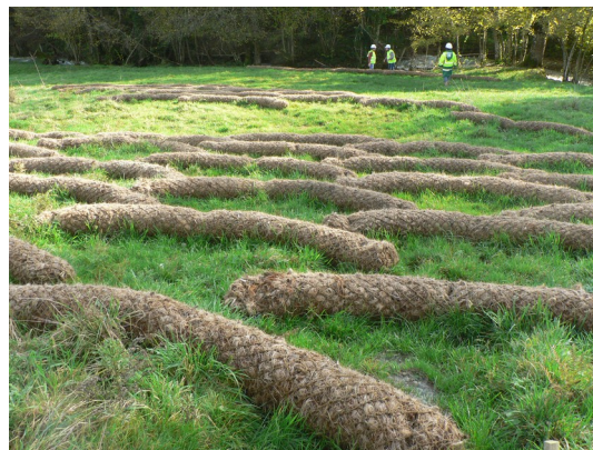
Crédit photo : Cerema Dispositif préventif de lutte contre une pollution : boudins "coco" jouant un rôle de filtre temporaire
