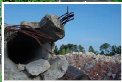
Matériaux de déconstruction
