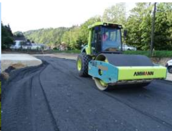
Chantier La Cluse et Mijoux (25)
