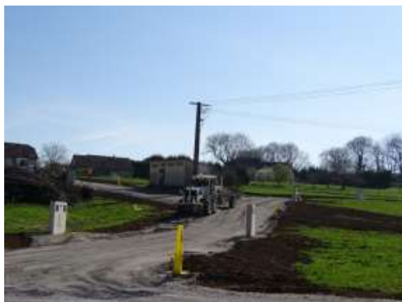
Chantier de Valdahon (25)
