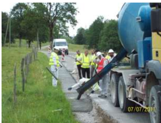
Utilisation des mâchefers en poutre de rive (Bugny-25)
