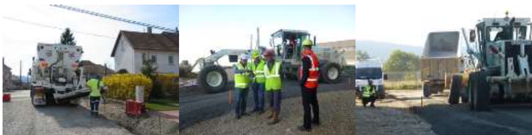
Exemples de chantiers de mise en œuvre
