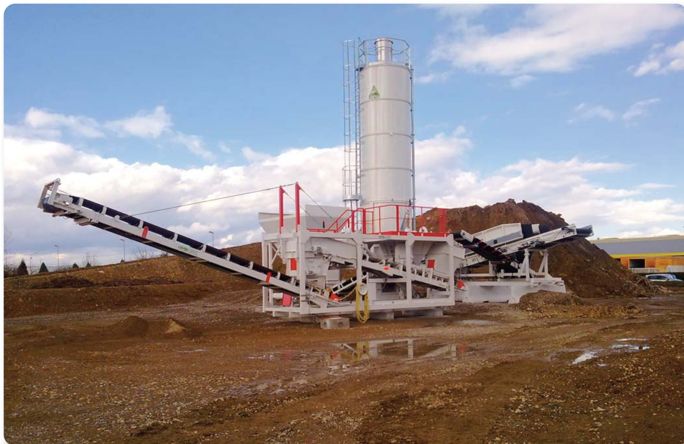
Exemple d'installation fixe - © CETE de Lyon
