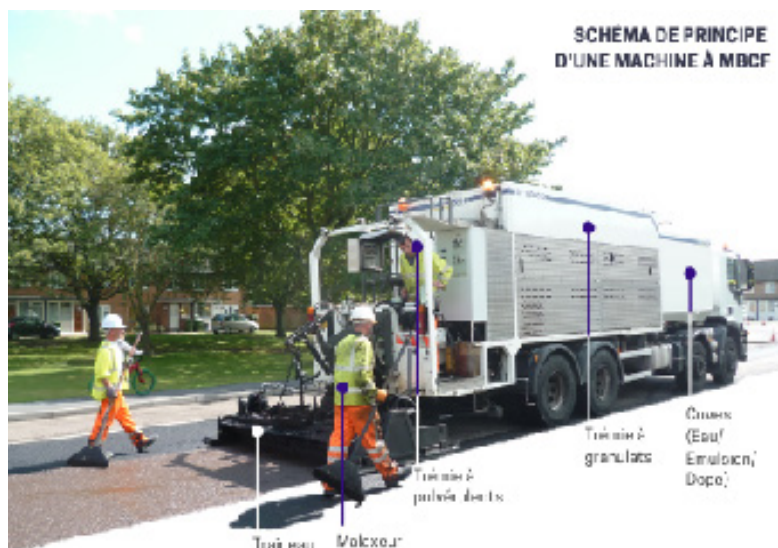
Figure n°2 : Synoptique d'une machine MBCF et vue du traineau d'application
