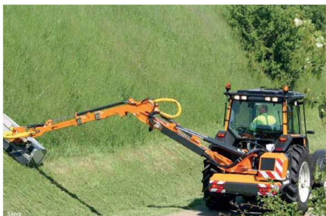
Figure 10 : Fauchage d'un talus en remblai
