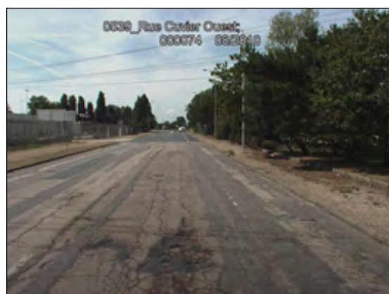
Figure 4 : Exemple sur un même pas de 200 m. Etat neuf sur la première partie du tronçon (à gauche), puis très dégradé sur la seconde partie (à droite)
