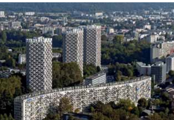
L'immeuble en S et les trois tours de l'Île Verte, à Grenoble.
