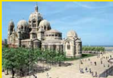
Le projet ambitieux de réaménagement urbain Euromed II, labélisé Ecocité, à Marseille.
