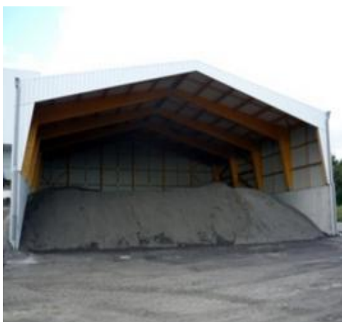
Photo 3 – Stockage de granulats sous abri
