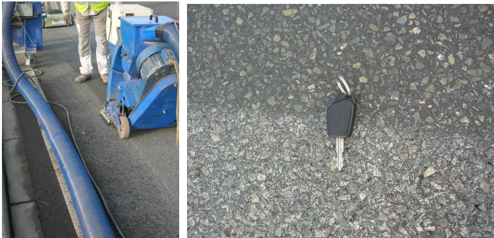
Figure 26 : Exemple de grenailage avec machine à faible rendement (CG28)
