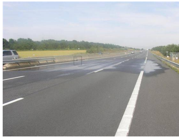
Figure 3 : Conséquences de problèmes d'uni (Sources Département Laboratoire de St Brieuc et Charier SA).
