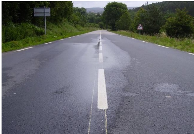
Figure 5 : Résurgence d'eau sur couche de liaison (Sources Département Laboratoire de Saint-Briec et Colas SA).
