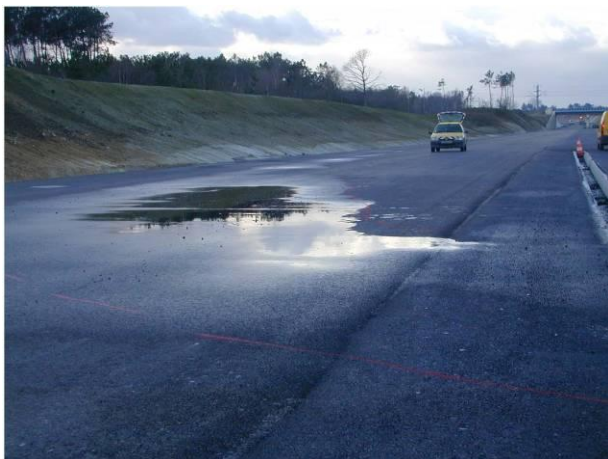
Figure 3 : Conséquences de problèmes d'uni (Sources Département Laboratoire de St Brieuc et Charier SA).
