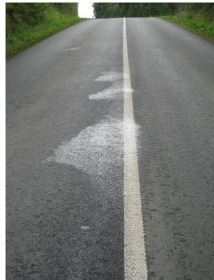
Figure 5 : Résurgence d'eau sur couche de liaison (Sources Département Laboratoire de Saint-Briec et Colas SA).
