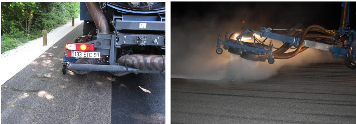
Figure 27 : Exemple d'hydrorégénération (appareil Ultra haute pression - Néovia Technologies)
