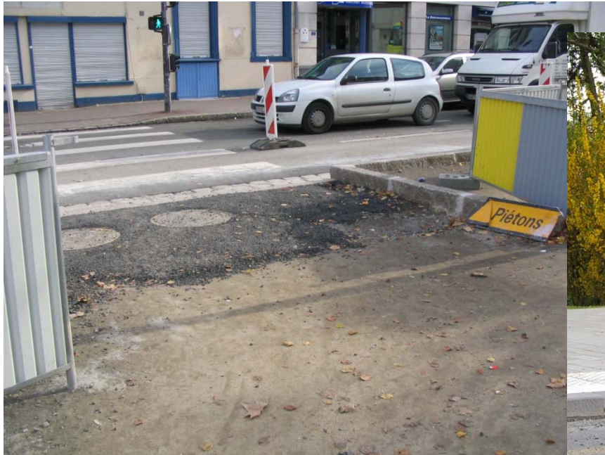
Aménagements provisoires en enrobés
