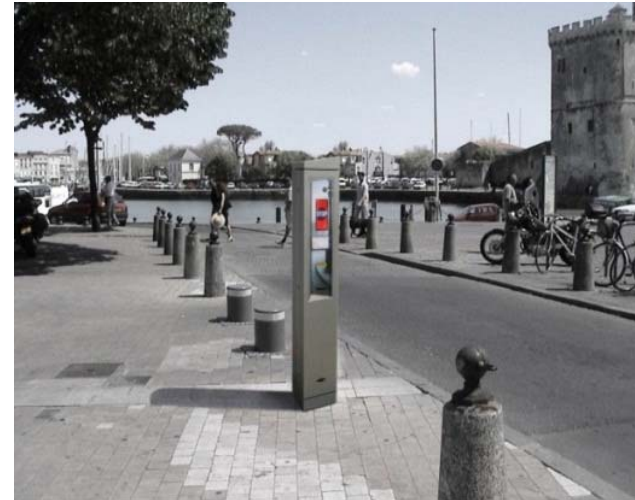
Contrôle d'accès véhicules PMR
