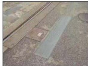
Illustration 3: Rechargement gravillonné ou résine : Caen – lignes A et B
