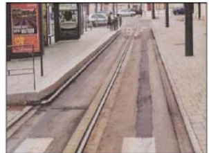
Illustration 1: Rechargement des ornières à la résine : Nancy – station Essey/Roosevelt
