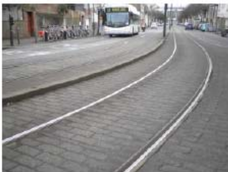
Système d'affaiblissement vibratoire: les pavés pianotent le long du rail
