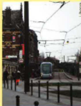
Valenciennes : un exemple de matériaux différents sur la plate-forme
