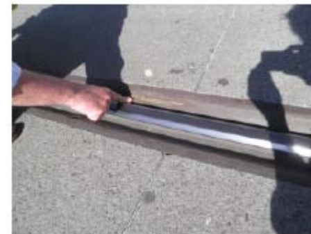
Pathologie du profilé PU encadrant le rail
