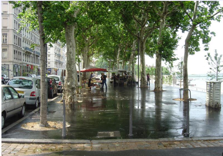
Asphalte industriel : zone de marché
