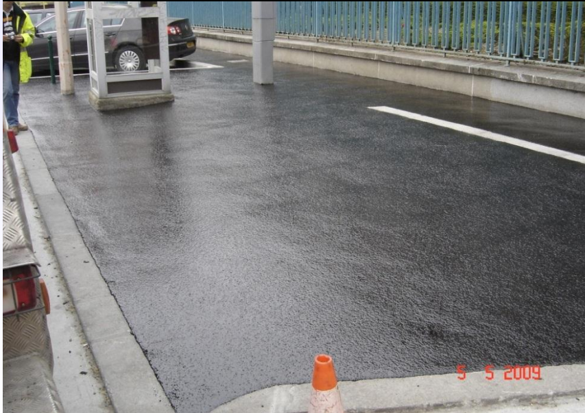
Aspect après mise en œuvre
