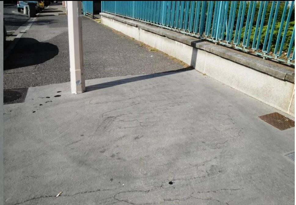
Tâches d'huile et d'écoulement des eaux de pluie
