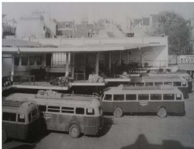
Photo 8 : gare de Caen (1938, fermée en 1979, démolie en 1986) avec une innovation majeure : on charge sur le toit au moyen d'une passerelle
