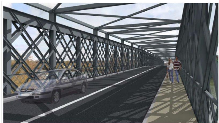
Pont de Belleville Ré-hausse de la traverse supérieure (Rhône)
