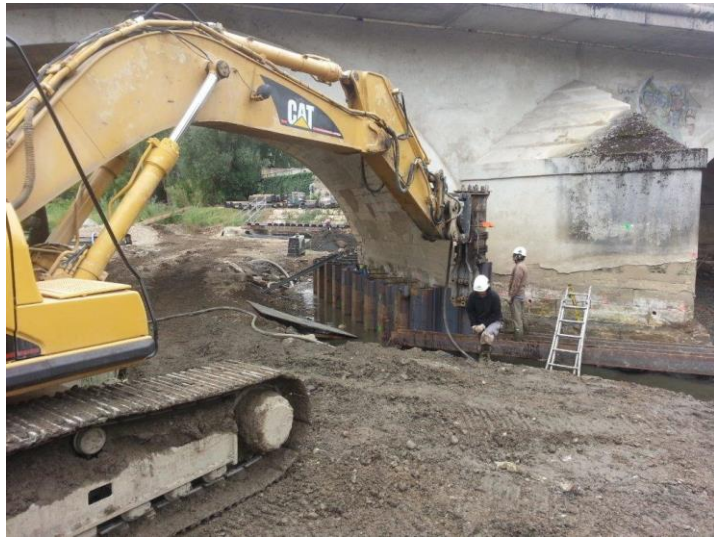
Des opérations d'entretien menées souvent « dans l'ombre » Source Département Rhône
