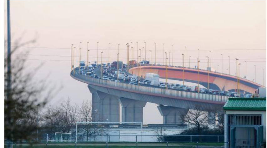
Des opérations d'entretien sources de nuisances Nantes. Le pont de Cheviré fermé, quel bazar ! Source Ouest France
