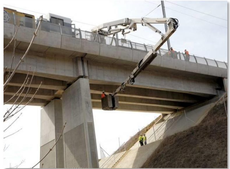
Plate-forme ferroviaire classique
