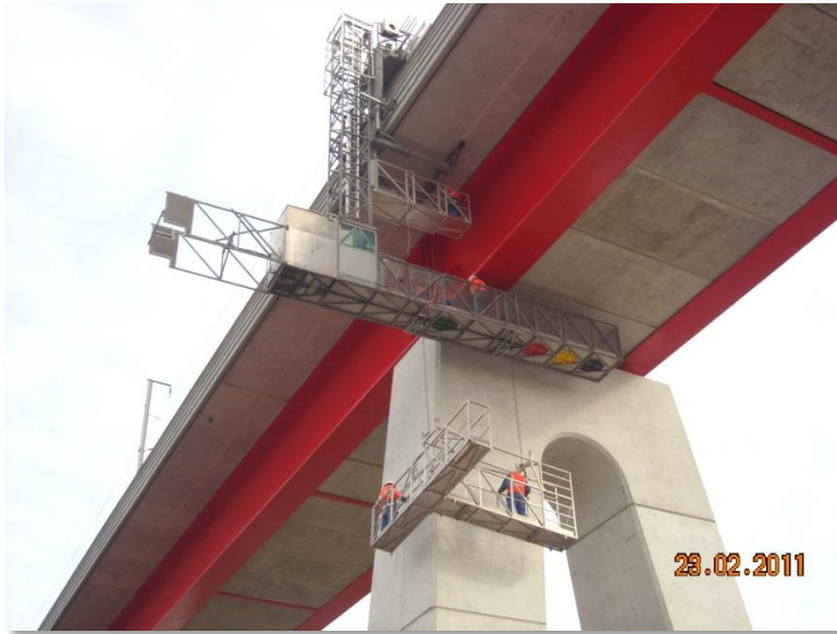
Plate-forme légère roulant sur la piste (peu de gêne sur les circulations), sur LGV
