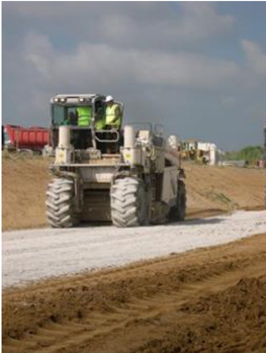
Sol avant traitement
