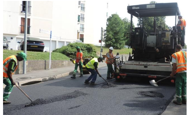
Mise en œuvre mécanisée et finitions manuelles (enrobé pré-compacté)
