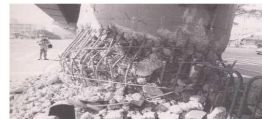
Figure 1 : Pied de pile - rupture sous séisme
