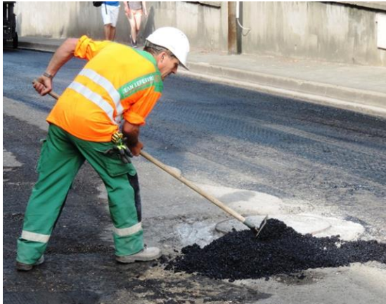
Mise en œuvre manuelle (enrobé foisonné)
