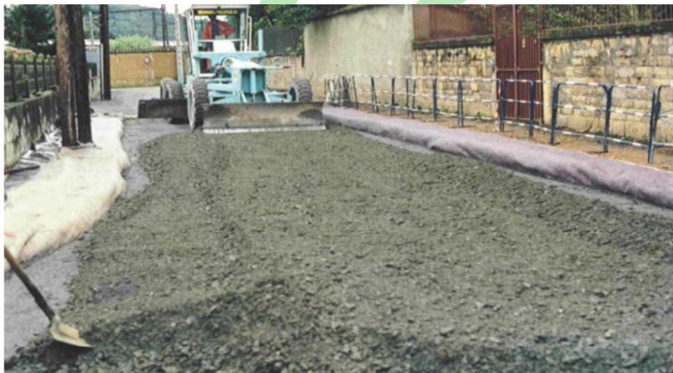
Collonges (69) : réalisation d'un plot routier en mâchefers d'incinération de déchets non dangereux (MIDND) (source Cerema)
