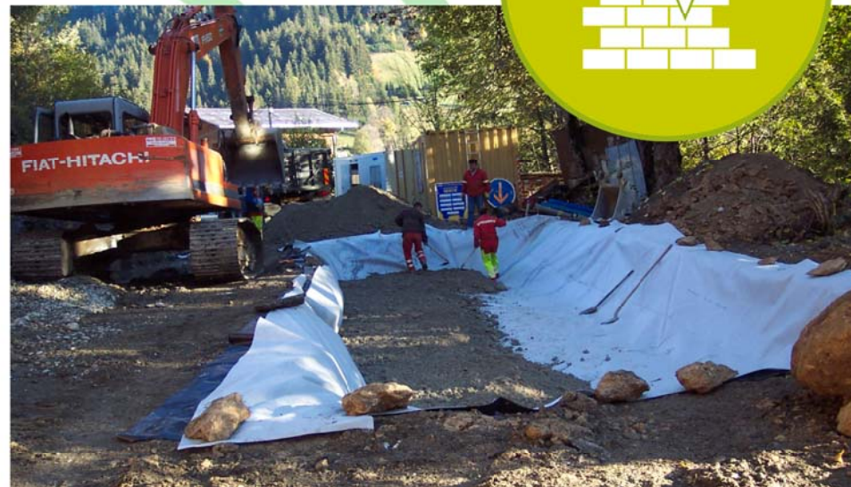
Hauteluce (73) : réalisation d'un plot routier en laitier sidérurgique (source Cerema)
