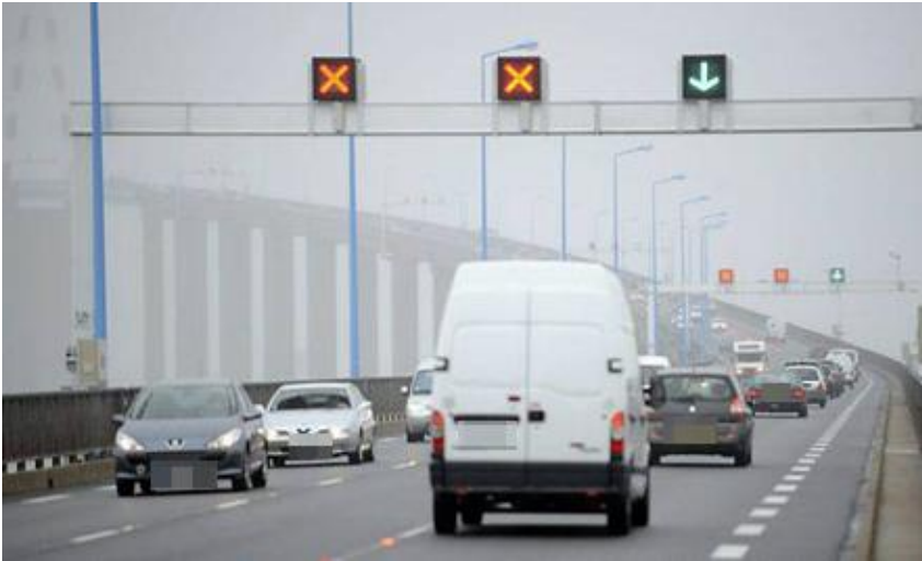
Pont de Saint-Nazaire
