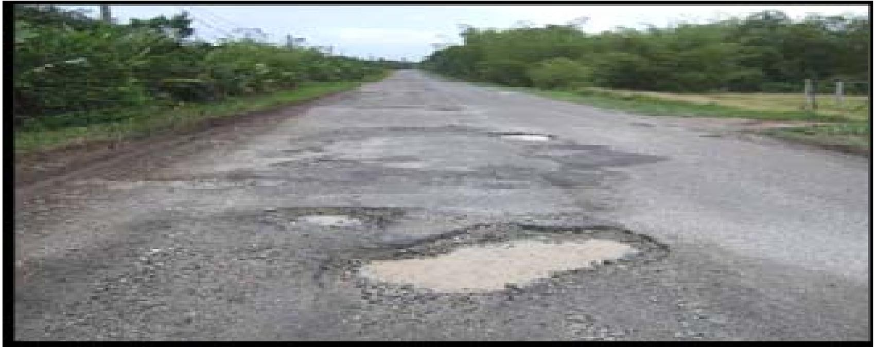
Dégradation de la couche de surface entraînant une détérioration, dans un second temps, importante de la route : dégradation observable sur certaines routes ou autoroutes du Nord de la France et de l'Île de France
