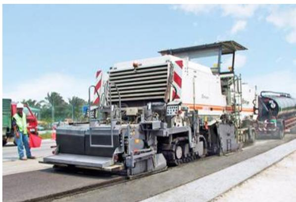
**Retraitement en place à froid des chaussées au liant hydraulique (RTLH)**
