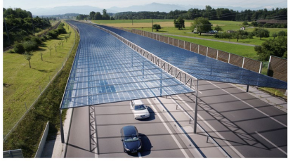
Crédit : Autoroute avec un toit solaire - Labor3.ch
