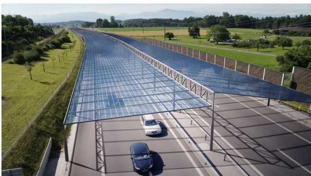
Crédit : Autoroute avec un toit solaire – labor3.ch
