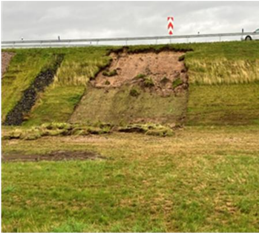
Glissement de terrain
