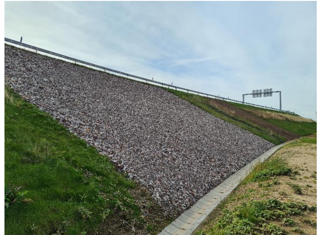
Réparation du dommage
