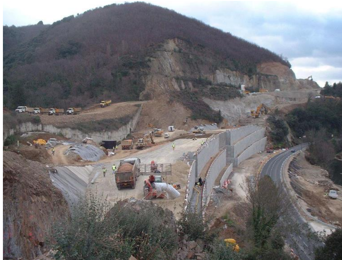
Construction d'un mur de soutènement en terre armée
