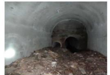
Voûte en béton projeté
