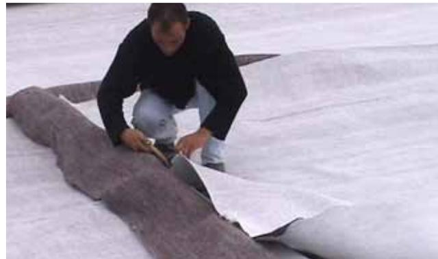
Figure A3 et photo A6 : Traitement des jointes transversales (bout à bout)
