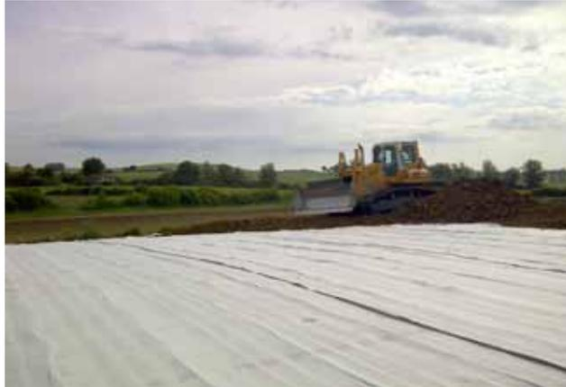
Photo A5 : Mise en œuvre des géocomposites de la gamme SOMTUBE 850 FTF D20
