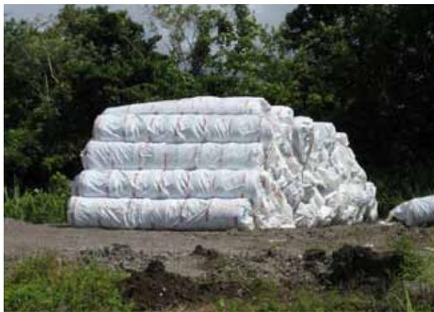
Photo A4 : Stockage des rouleaux des géocomposites de la gamme SOMTUBE 850 FTF D20
