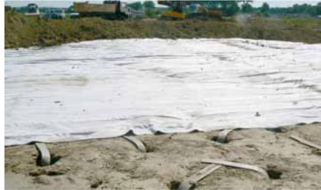
*Photos A10 et A11 : connexion hydraulique drains verticaux - géocomposites de la gamme SOMETUBE 850 FTF D20*
