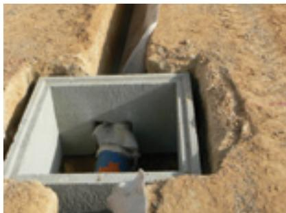
Photo 8 : Raccordement du DRAINCOTEX 200 au regard
