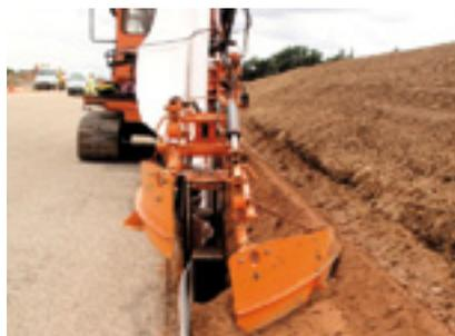
Photos 6 & 7 : Mise en place mécanisée du DRAINCOTEX 200
