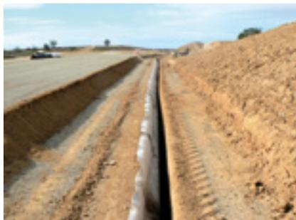
Photo 3 : Mise en place du DRAINCOTEX 200
