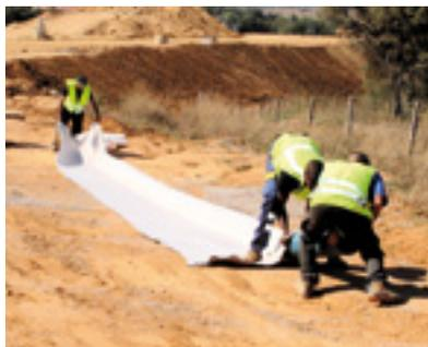
Photo 1 : Insertion du drain collecteur
