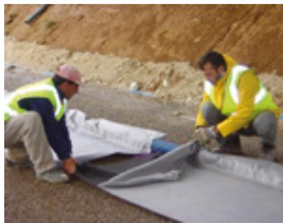
Photo 2 : Assemblage des rouleaux
