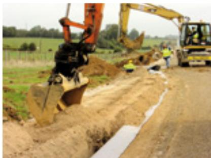
Photo 4 : Remblaiement de la tranchée
