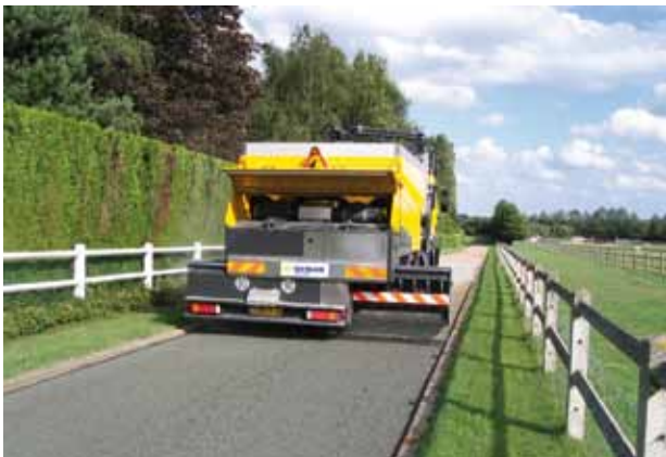
Figure 4. Répandeur gravillonneur synchrone (droits Secmair)
