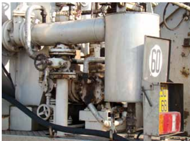
Figure 7. Filtre à liant (droits SEMR)
