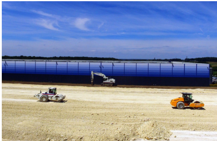
► Chantier de mise en œuvre de craie
