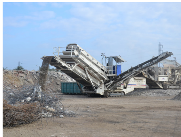
► Concassage criblage de poteaux béton déposés - SMC
