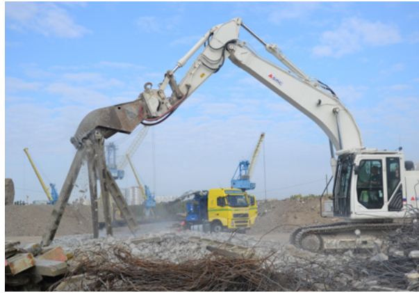
► Broyage de poteaux béton déposés (14) - SMC
