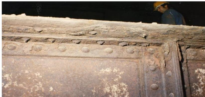
**Figure 40 : Dégradation des têtes de rivet par corrosion (photo Jean-Paul PERSY).**
