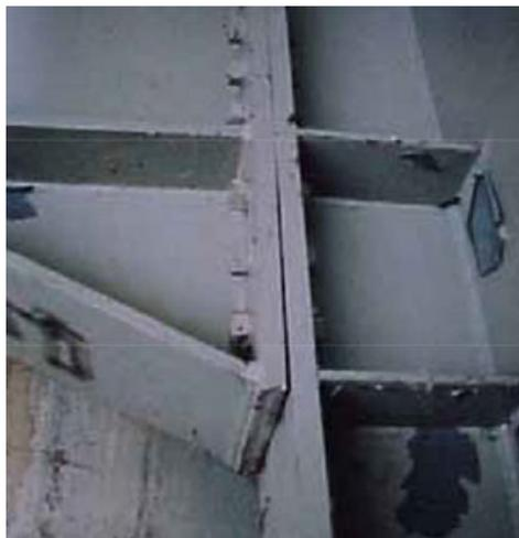
*Fig. 128 : Assemblage par boulons HR sollicités parallèlement à l'axe des boulons - défaut d'alignement dû au retrait de soudage (photo Jean-Paul PERSY).*
