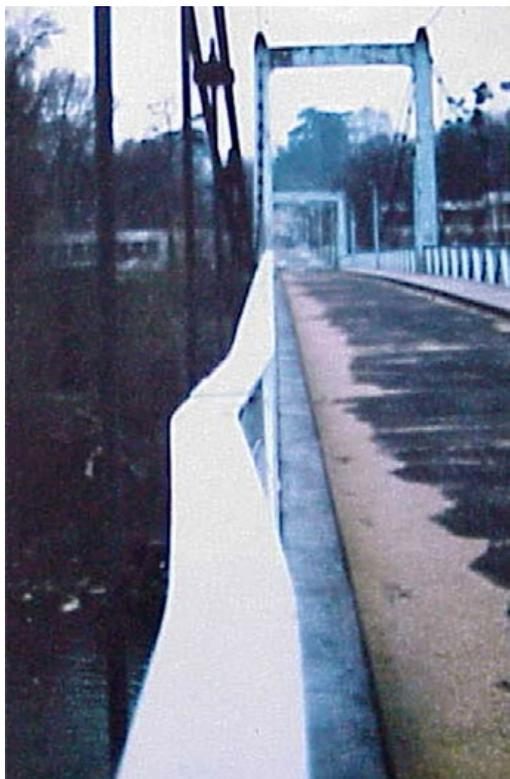
Figure 84 : Flambement de membrure supérieure de la poutre de rigidité hors du plan (photo Jean-Paul PERSY).
