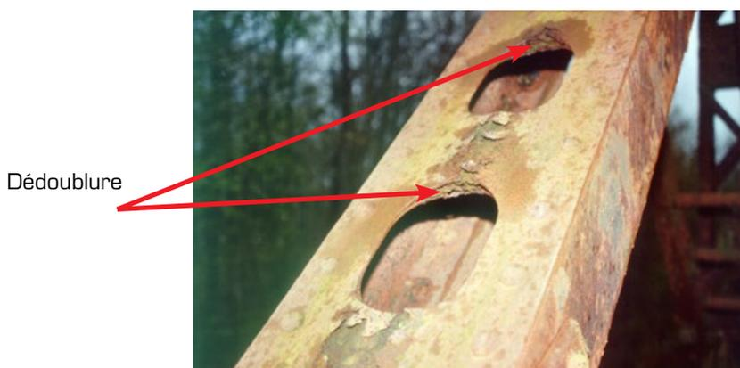
Figure 34 : Corrosion foisonnante sur dédoubleure sur une poutre caisson élévie (photo Jean-Paul PERSY).
