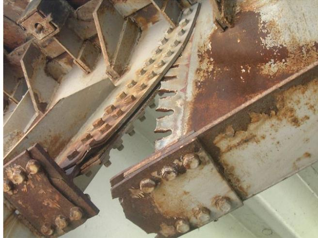
*Figure 75 : Sur ouvrage d'art, rupture par dépassement des efforts en pression diamétrale pour l'âme, par excès de traction pour le couvre-joint de la membrure inférieure (photo Jean-Paul PERSY).*
