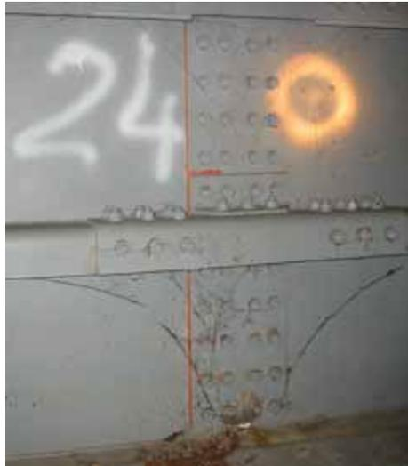
Fig. 71 : Glissement des pièces au niveau d'un joint de rabotage sous effort excessif (effondrement partiel de l'ouvrage). Mise en évidence par rupture du feuil de peinture et mise à nu de la sous couche au minium de plomb (photo Jean-Paul PERSY).
