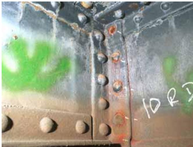
Fig. 93 : Déconsolidation d'assemblage rivé avec rupture de rivet (photo SNCF).
