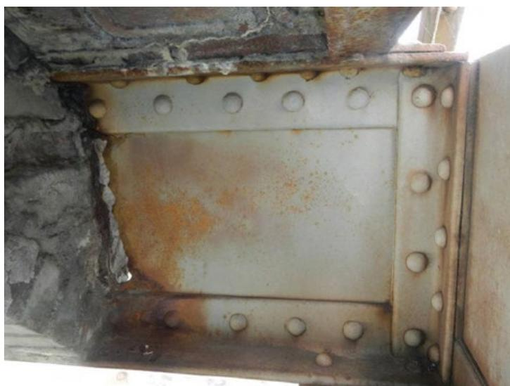
**Figure 43 : Corrosion de pièce noyée dans la maçonnerie. Perforation de l'âme, corrosion des cornières de membrures au contact de la maçonnerie (photo Jean-Paul PERSY).**
