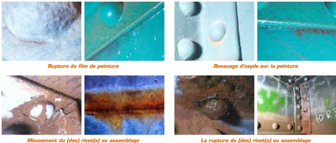
Fig. 65 : Dégradation des rivets (à gauche) et assemblages (à droite) par déconsolidation (photos SNCF).
