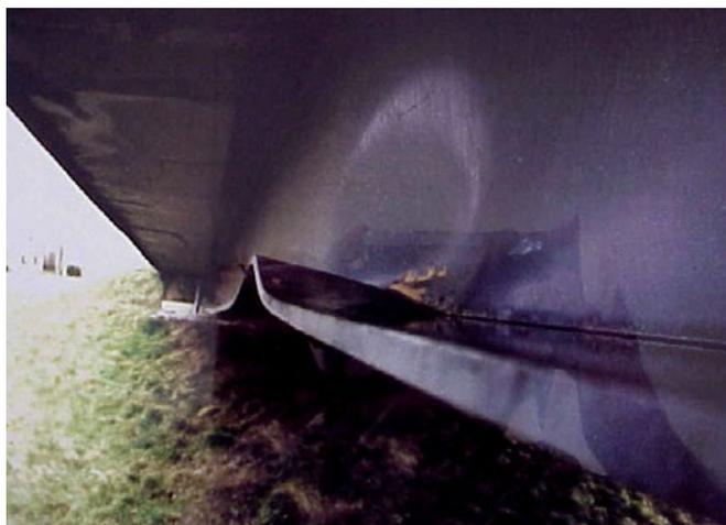
Figure 85 : Choc de véhicule sur ouvrage moderne - déformations de la membrure inférieure et de l'âme de poutre (photo Jean-Paul PERSY).
