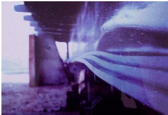
Figure 82 : Voilement d'âme en cours de lancement
