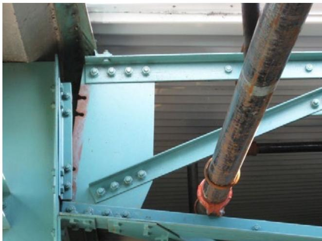
Figure 74 : Rupture par dépassement des efforts en pression diamétrale sur une charpente (photo Jean-Paul PERSY).
