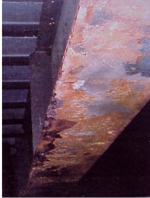
**Figure 31 : Enrouillement, et début de corrosion sur zone condensante en sous-face d'une membrure inférieure de pièce de pont (photo Jean-Paul PERSY).**
