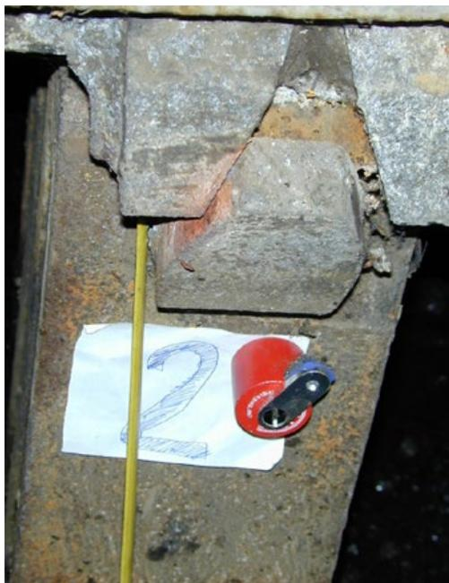
**Figure 102 : Rupture du dispositif anti-cheminement sur appareil d'appui à balancier** (photo Yves Picard).
