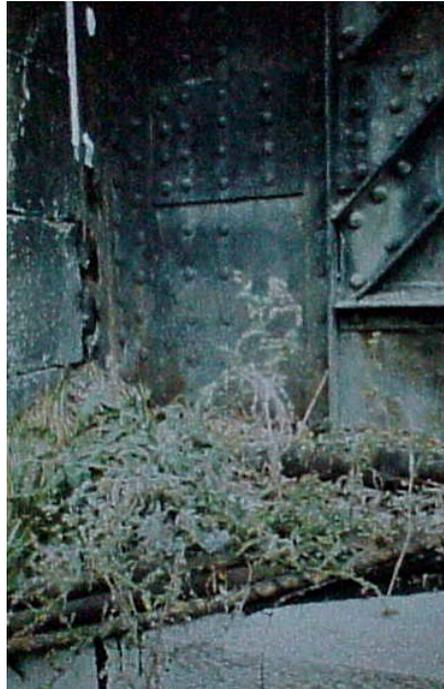
Figure 29 : Piège à poussière, maintien de l'humidité, végétation, foyer de corrosion (photo Jean-Paul PERSY).
