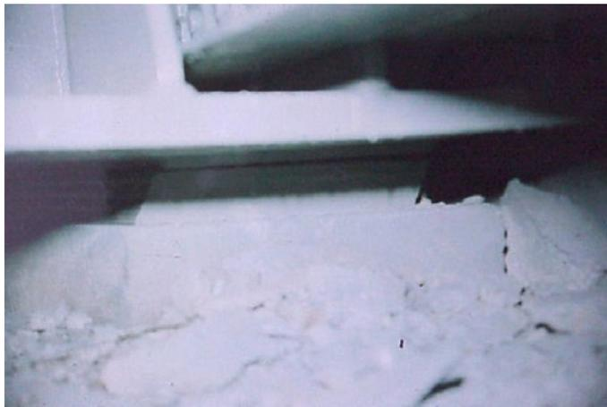
Figure 105 : Défaut de contact d'un appareil néoprène par défaut de parallélisme des surfaces (photo Jean-Paul PERSY).
