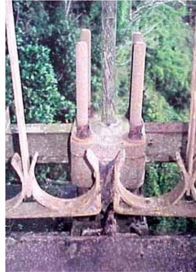
**Fig. 69 : Corrosion spécifique des écrous d'une attache basse de suspension de pont suspendu (photo Menou - LCPC).**
