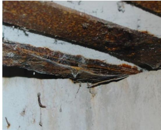
**Figure 32 : Corrosion feuilletante d'une membrure inférieure d'une poutre d'un pont à poutrelles enrobées (photo Jean-Paul PERSY).**
