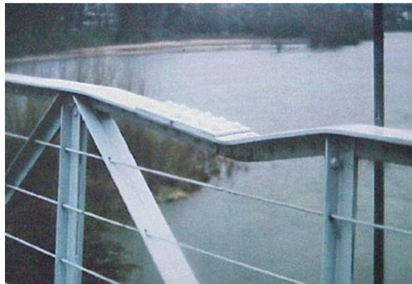
Figure 83 : Flambement de membrure supérieure de la poutre de rigidité dans le plan (photo Jean-Paul PERSY).
