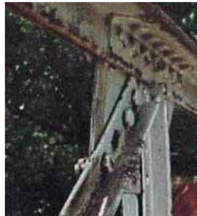
**Fig. 70 : Déconsolidation d'un assemblage boulonné non précontraint d'une poutre treillis avec disparition d'un boulon de l'assemblage (photo Jean-Paul PERSY).**
