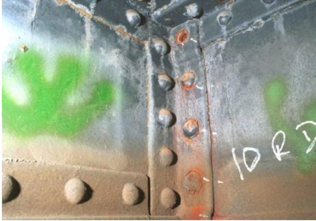
Figure 66 : Différents stades de déconsolidation d'un assemblage rivé (photo SNCF).
