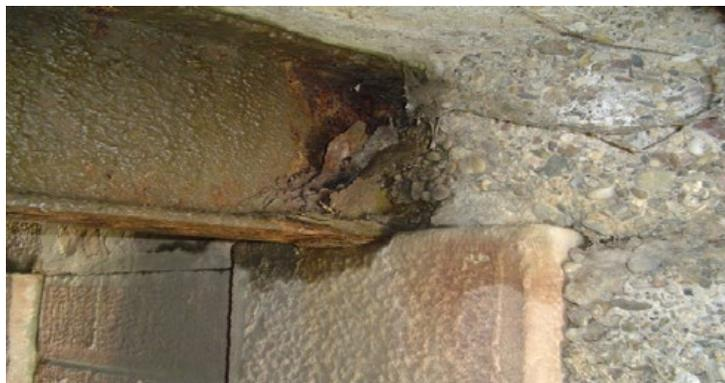
**Figure 42 : Dégradation, avec écrasement de la zone d'appui d'une poutre encastrée, affaiblissement par corrosion (photo Jean-Paul PERSY).**
