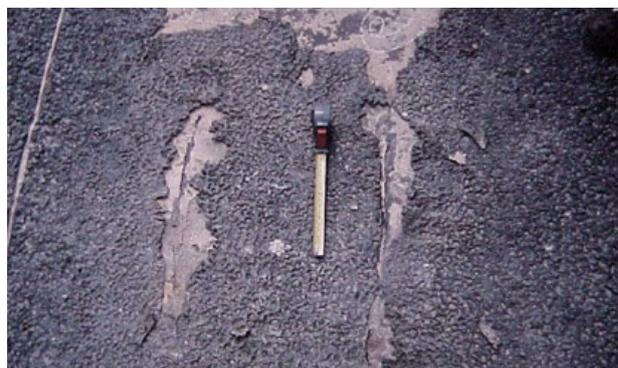
Figure 57 : Fissuration par fatigue de tôle de platelage sous l'effet de la circulation - ici platelage de 10 mm sur autoponts (photo Jean-Paul PERSY).
