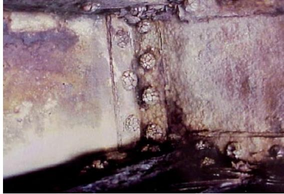
**Figure 39 : Corrosion des têtes de rivet, risque de perte de résistance à la traction sous tête (photo Jean-Paul PERSY).**
