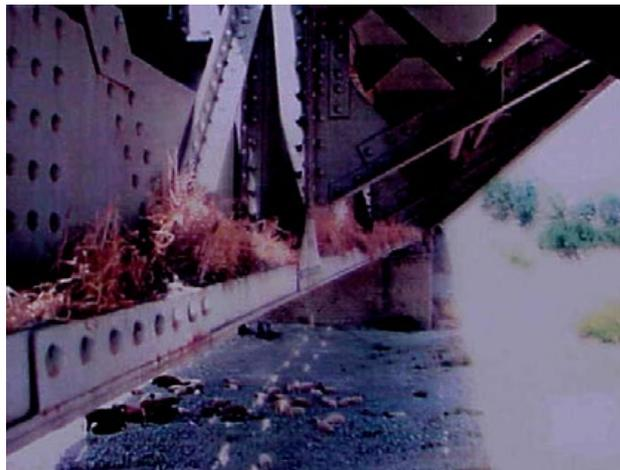
Figure 30 : Renforts de membrure inférieure formant piège à eau et / ou piège à poussière (photo Jean-Paul PERSY).
