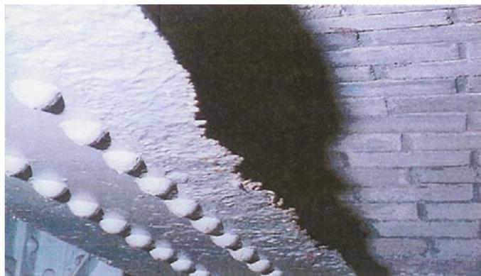
**Figure 41 : Membrane inférieure corrodée latéralement, conservée après vérification par calcul et traitement anticorrosion (photo Jean-Paul PERSY).**
