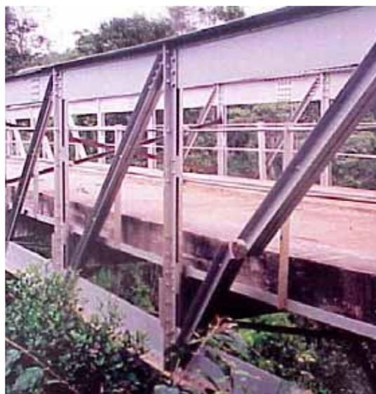
Fig. 21 : Rupture d'une diagonale tendue sur un point de soudure (photo Jean-Paul PERSY).
