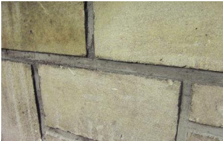
Photo n° 55 : finition sciée (crédit photo D. Poineau)
