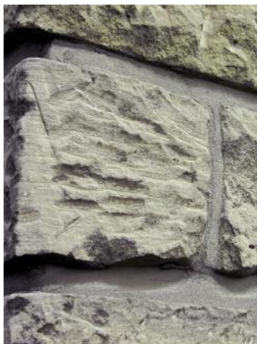
Photo n° 56 : finition brochée (crédit photo D. Poineau)
