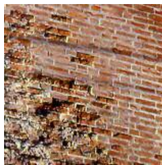
Photo n° 11 : désorganisation locale d'un parement en briques (crédit photo J. M. Michotey)
