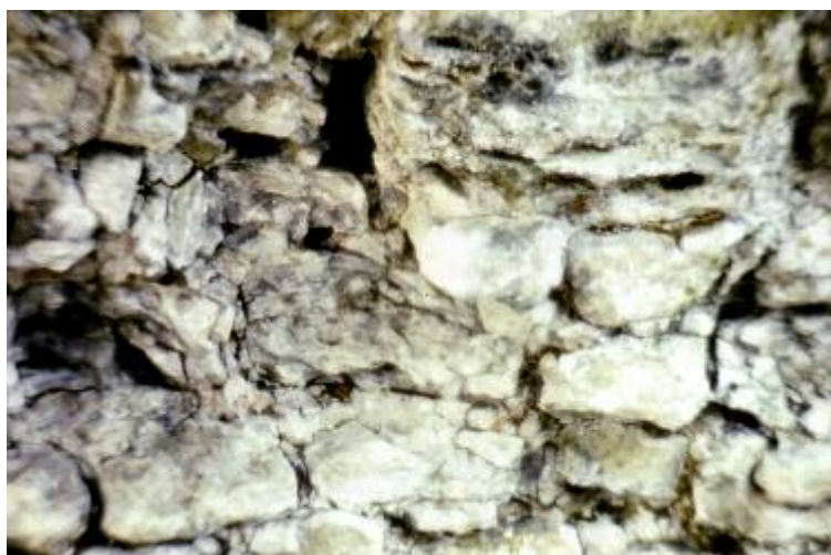
Photo n° 14 : exemple d'emploi de matériaux inadaptés : pierres et mortier de hourdage (crédit photo LRPC)
