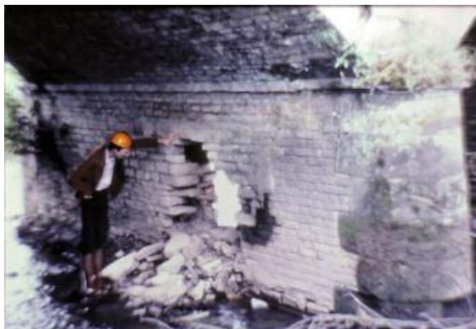
Photo n° 9 : désorganisation de la maçonnerie d'une pile (photo CDOA 70)
