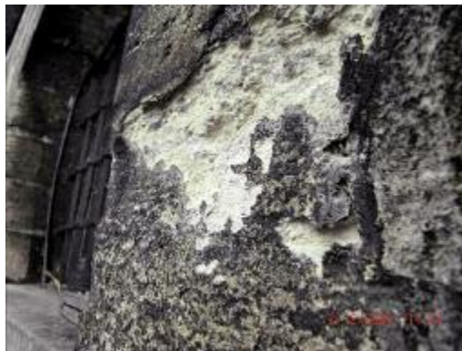
Photo n° 27: desquamation de pierres calcaires de l'église de Villejuif (crédit photo D. Poineau)
