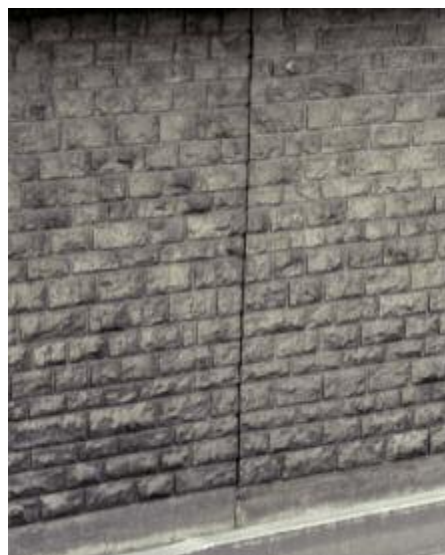
Photo n° 32 : joint de fractionnement (photo D. Poineau)
