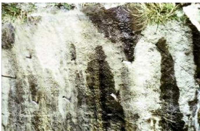
Photo n° 63 : coulures d'eau et de calcite (crédit photo CDOA Corse)
