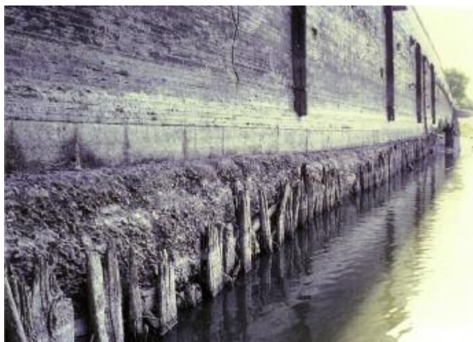
Photo n°43 : dégradation par abrasion d'une pièce de bois de fondation (crédit photo J. P. Levillain)
