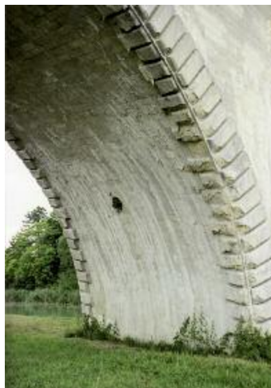
Photo n° 16 : coulures d'humidité et de calcite et pierres sensibles au gel sous un ancien pont ferroviaire (crédit photo DDE 52)
