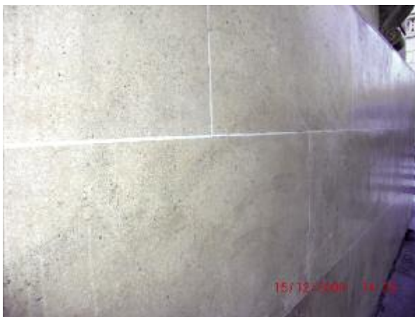
Photo n° 65 : revêtement anti-graffiti permanent sur un mur à Paris (crédit photo D. Poinneau)
