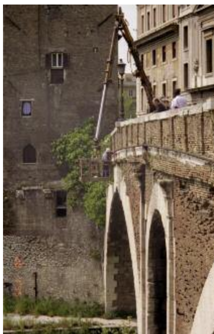
Photo n° 60 : dévégétalisation sur le pont Fabricio à Rome (crédit photo D. Poineau)
