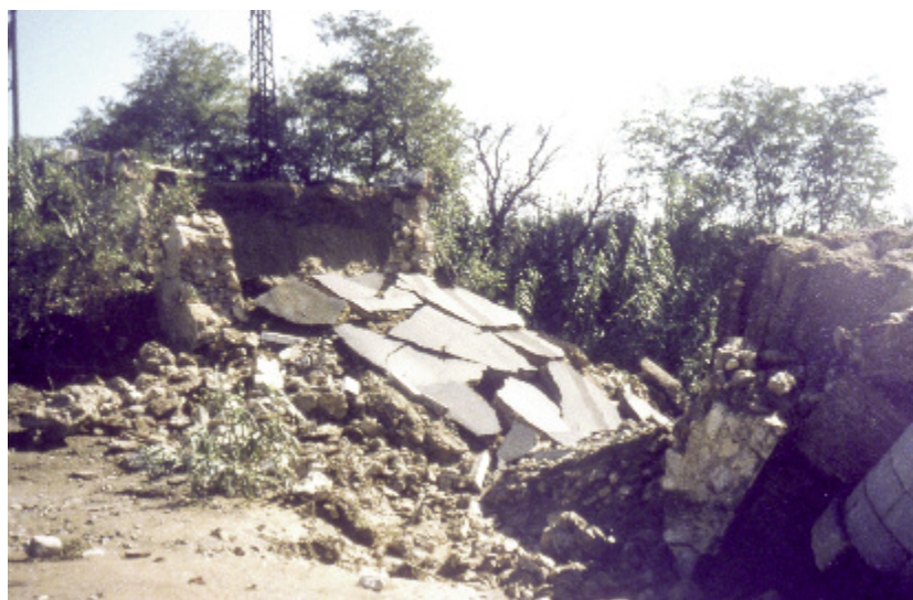
Photo n° 84 : effondrement du pont du Réart causé par des travaux sur les fondations (crédit photo D. Poineau)
