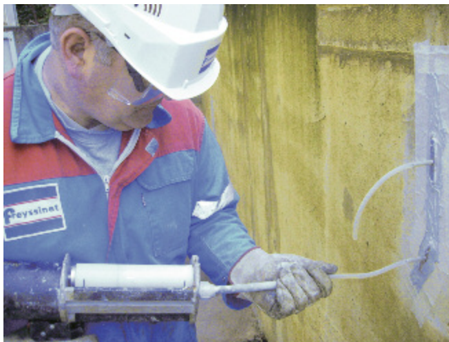
Photo n° 58 : pistolet manuel d'injection (crédit photo Freyssinet)
