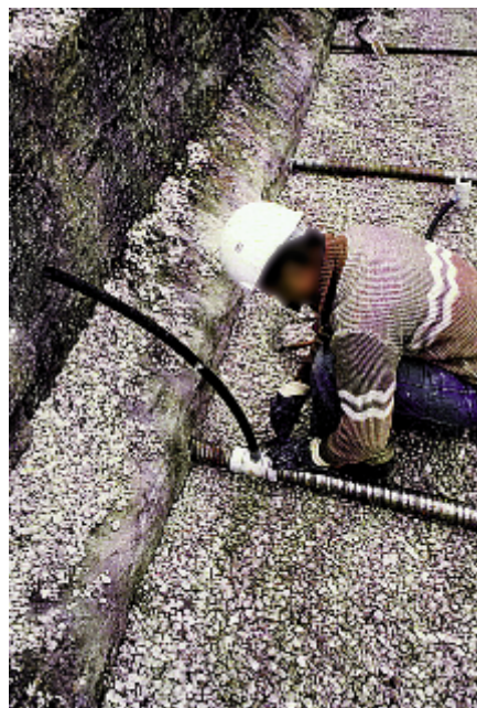
Photo n° 46 : mise en place d'armatures de précontrainte - cf. le nota 1 (crédit photo DDE 52)
