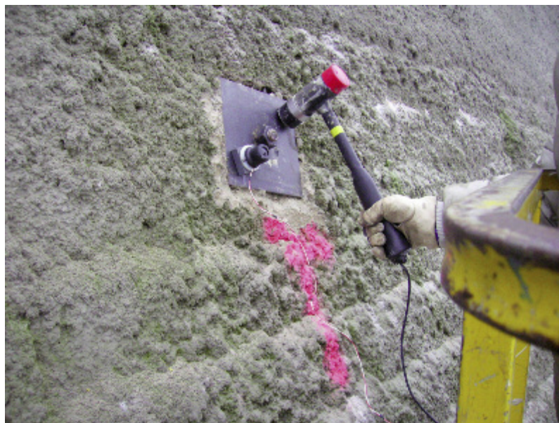
Photo n° 67 : acquisition des mesures (crédit photo A. Bouineau)
