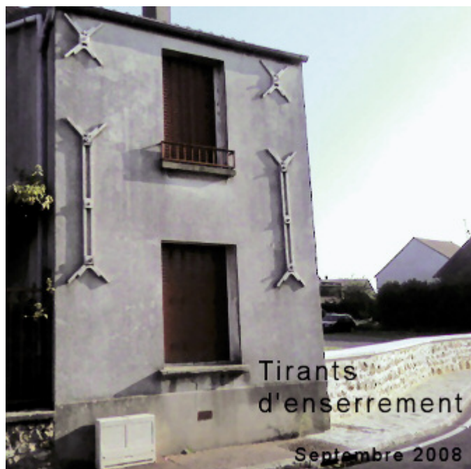
Photo n° 37 : tirants d'enserrement d'un pavillon en région parisienne (crédit photo D. Poinéau)
