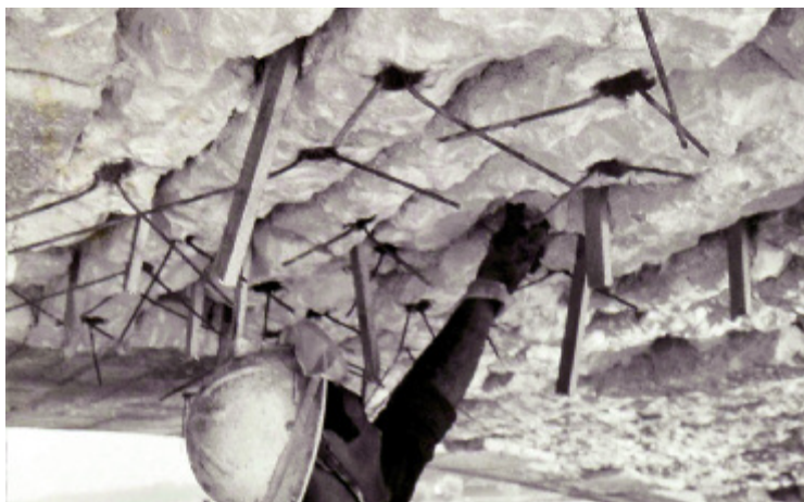
Photo n° 73 : scellement des épingles au pont de Favernay (crédit photo DDE 70)
