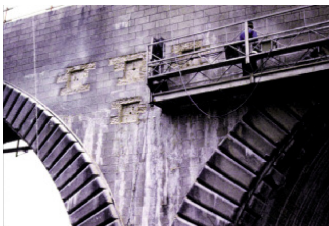
Photo n° 63 : pont dit de 100 mètres, niches de logement des ancrages (crédit photo DDE 52)
