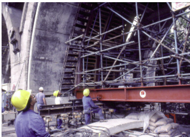
Photo n° 71 : déplacement de la contre-voûte préfabriquée (crédit photo D. Poinneau)
