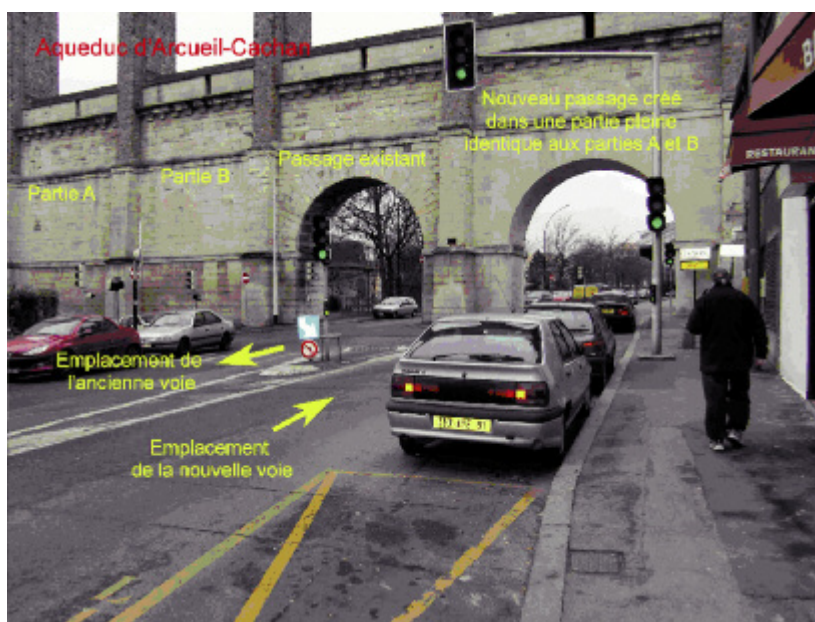
Photo n° 100 : création d'une nouvelle voûte sous l'aqueduc d'Arcueil-Cachan (crédit photo D. Poineau)
