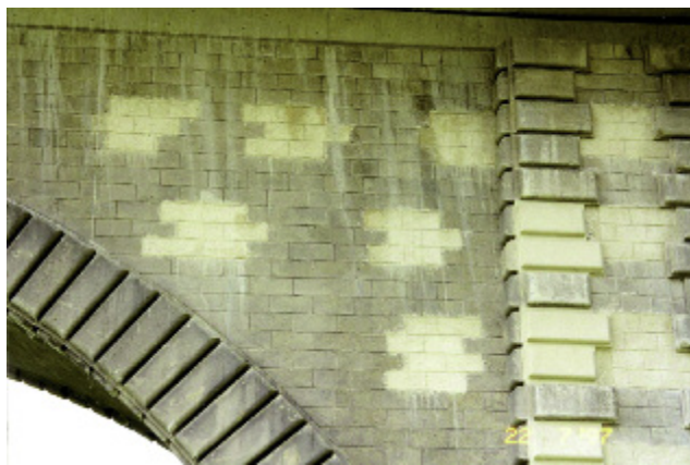
Photo n° 65 : pont dit de 100 mètres aspect des parties restaurées, le ravalement des maçonneries n'ayant pas été prévu au marché (crédit photo DDE 52)
