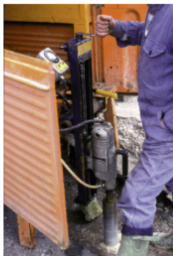
Photo n° 52 : carottage avec une couronne diamantée (crédit photo D. Poinneau)
