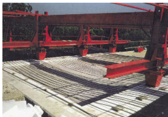
Photo n° 98 : équipement mobile utilisé pour la réalisation de la dalle générale d'élargissement du pont dit de 100 mètres (crédit photo DDE 52)
