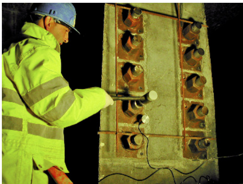
Photo n° 68 : acquisition des mesures (crédit photo A. Bouineau)
