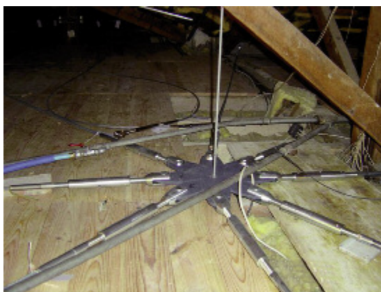
Photo n° 45 : pièce centrale permettant la mise en tension des tirants fixés sur les différentes plaques d'ancrage
