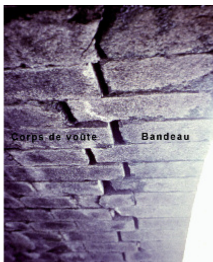
Photo n° 30 : décollement entre le bandeau et le corps de voûte du pont du nid d'oise à Clisson (crédit photo CETE de l'Ouest - Jacques Billon)
