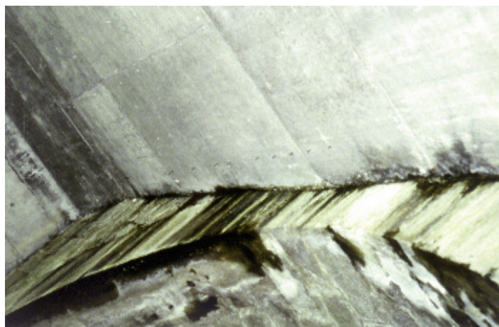
Photo n° 95 : mauvaise étanchéité du joint longitudinal entre l'ancien et le nouvel ouvrage (crédit photo CDDA Corse)
