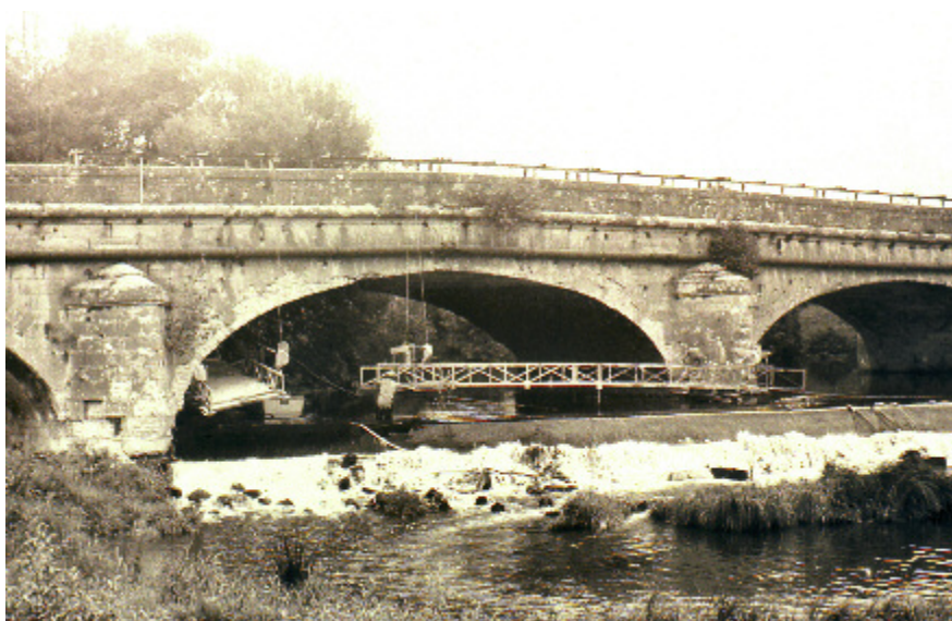
Photo n° 89 : pont surbaissé de Favernay qui pourrait être compatible (après réparations) avec une dalle générale appuyée sur le remplissage (crédit photo DDE 70)
