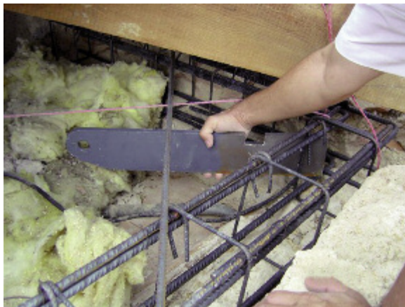
Photo n° 44 : chaînage périphérique en tête des murs extérieurs et plaque d'ancrage scellée dans le chaînage lors du bétonnage de ce dernier
