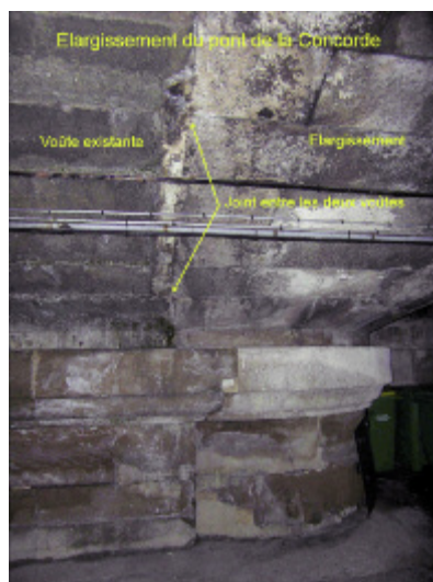
Photo n° 94 : détail de l'élargissement du pont de la Concorde (crédit photo D. Poineau)
