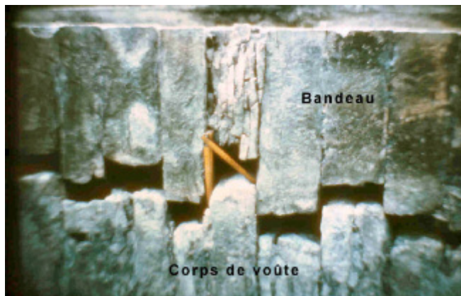
Photo n° 33 : combinaison de plusieurs désordres (décollement du bandeau, écrasement et fendage de pierres... (crédit photo LAPC)
