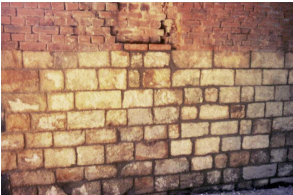
Photo n° 7 : travaux de réfection terminée pour la maçonnerie de moellons assisés (crédit photo JL. Michotey)
