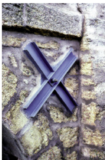
Photo n° 41 : tirant d'enserrement avec tête d'ancrage en croix de Saint-André. La protection de l'extrémité de la barre n'est pas assurée (crédit photo J.L. Michotey)
