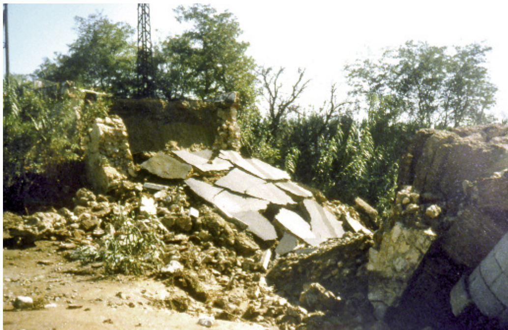
Photo n° 12 : effondrement d'un pont en maçonnerie en cours de travaux (crédit photo D. Poinneau)
