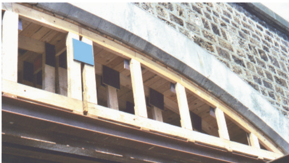
Photo n° 6 : soutènement pendant les travaux de confortement d'un pont à la Poterne des Peupliers (crédit photo D. Poineau)
