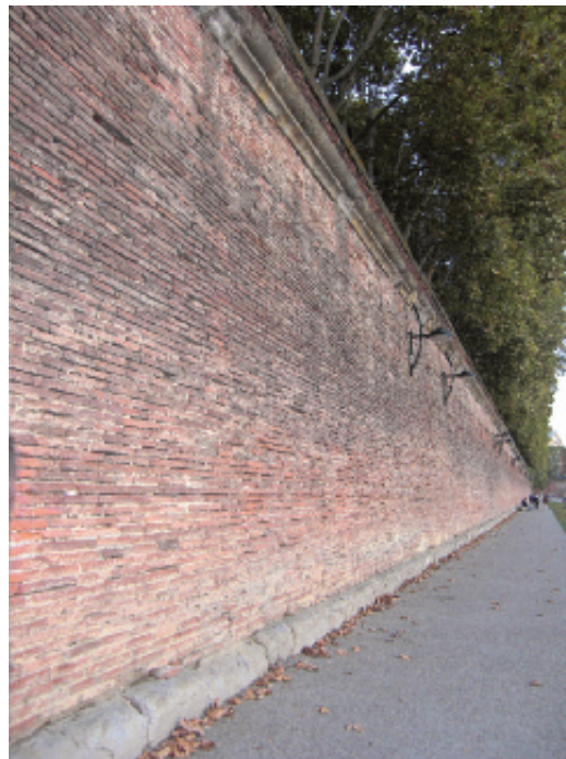
Photo n° 16 : mur de soutènement le long de la Garonne à Toulouse (crédit photo D. Poinéau)
