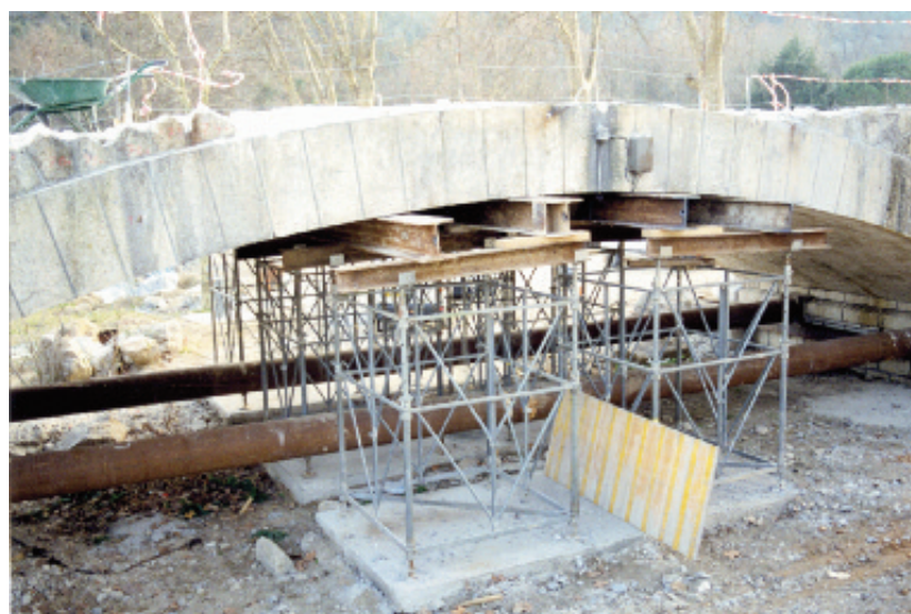
Photo n° 16 : butonnage des piles du pont de Villeneuve-Loubet (crédit photo P. Vion)
