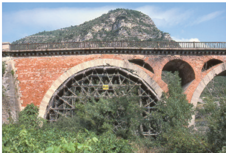
Photo n° 18 : cintre de sauvegarde (crédit photo CETE Méditerranée)
