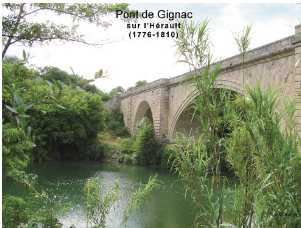
Photo n° 6 : pont de Gignac sur l'Hérault construit entre 1776 et 1810 [crédit photo Parexlanko]
