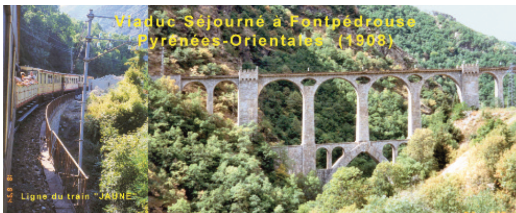
Photo n° 1 : viaduc de Fontpédrouse (crédit photo D. Poinneau)
