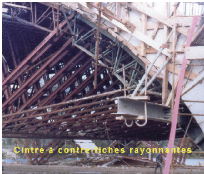
Photo n° 15 : détails du cintre utilisé lors de la reconstruction partielle du pont Wilson à Tours (crédit photo D. Poinneau)
