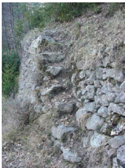
Photo n° 15 : mur de soutènement et escalier en pierres sèches (crédit photo http://environnement.ecoles.free.fr )
