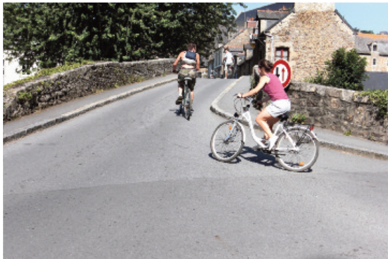
Photo n°1 : pont en maçonnerie où l'évacuation des eaux ne pose pas de difficultés (crédit photo D. Poineau)
