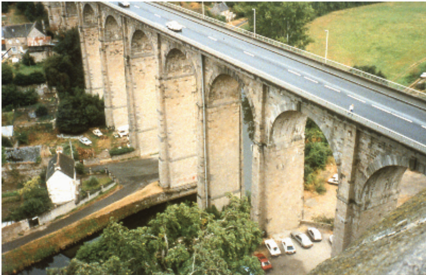
Photo n° 8 : viaduc de Dinan dans les Côtes d'Armor (crédit-photo D. Poinéau)
