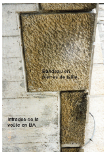
Photo n° 4 : détail de la jonction voûte bandeau du pont de Montereau (crédit photo D. Poineau)
