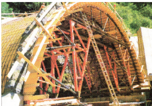
Photo n° 13 : cintre métallique (crédit photo PERI)
