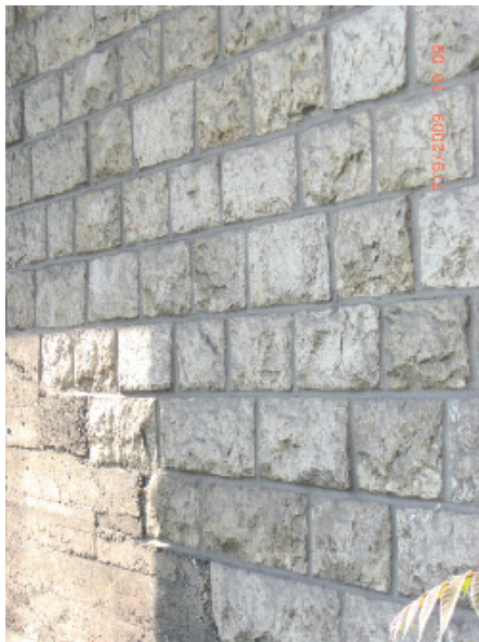
Photo n° 17 : mur mixte associant la maçonnerie et le béton (crédit photo D. Poineau)
