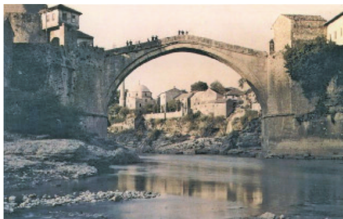
Photo n° 20 : pont de Mostar (crédit photo A. Bouineau)
