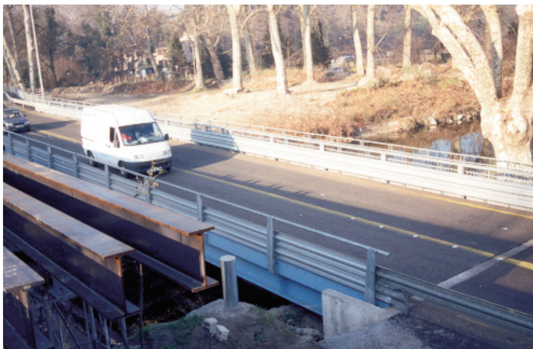
Photo n° 3 : pont provisoire à Villeneuve-Loubet pendant les travaux de réparation du pont en maçonnerie (crédit photo P. Vion)
