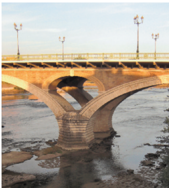
Photo n° 7 : pile de section optimisée du pont Catalans (ex-pont des Amidonniers) à Toulouse (crédit-photo D. Poinéau)
