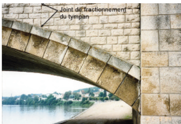
Photo n° 3 : arc en BA habillé de pierres du pont de Montereau (crédit photo D. Poineau)
