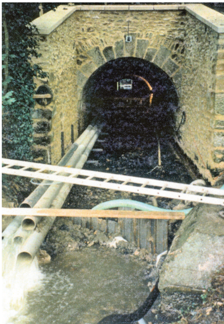
Photo n° 4 : double batardeau et canalisation provisoire de la Bièvre sous l'aqueduc de Buc (crédit photo DDE 78)
