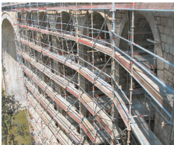
Photo n° 5 : échafaudage pour l'accès au pont des Albarines (crédit photo CG du Gard)
