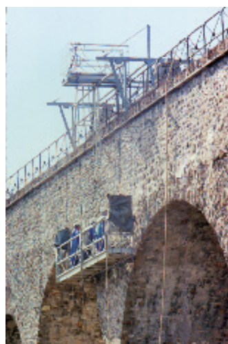
Photo n° 2 : aqueduc d'Arcueil-Cachan, échafaudage volant pour des travaux de ragréage (crédit photo D. Poinéau)
