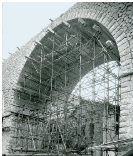
Photo n° 17 : cintres en tubes et raccords (crédit photo Entrepouse Echafaudages)
